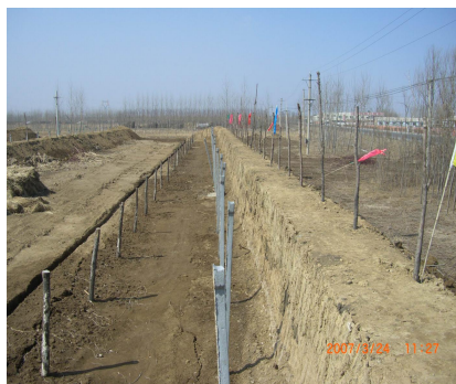
图 3 夯土墙施工
